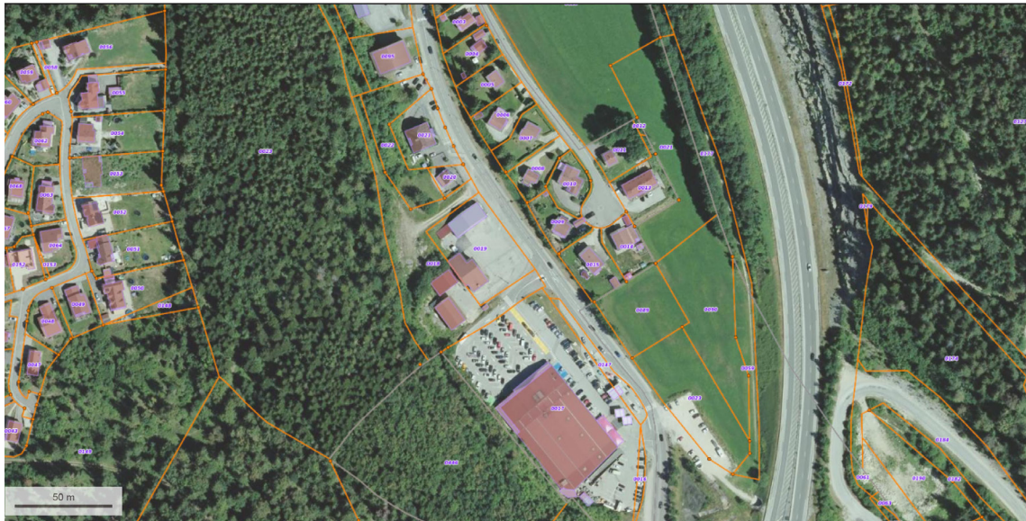
PHOTO AÉRIENNE GÉOPORTAIL SECTEUR SUD
