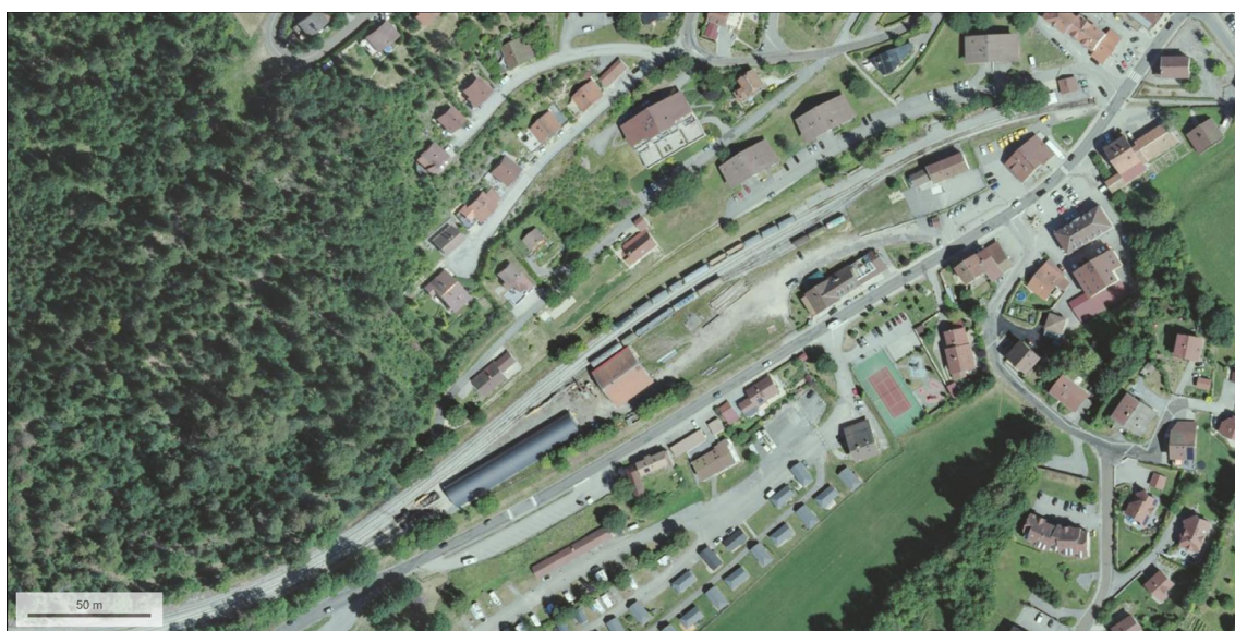
PHOTO AÉRIENNE GÉOPORTAIL SECTEUR ANCIENNE GARE
