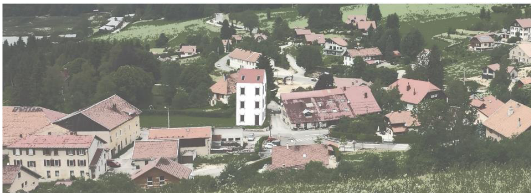
Illustration d'une mauvaise insertion paysagère (source : CAUE25)
