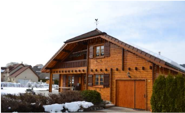
Une maison récente en bois – Source : DORGAT
