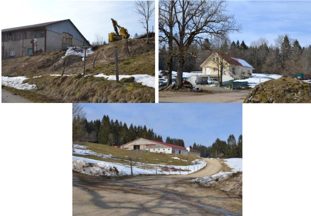
Figure 10 : Hangars et maison non identifiés comme pouvant faire l'objet d'un changement de destination – Source : DORGAT
