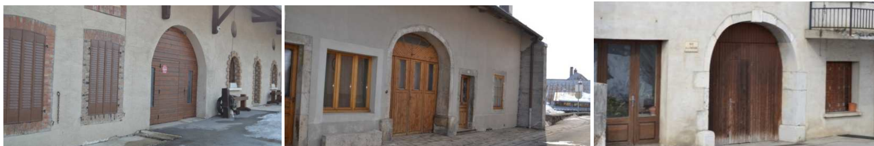
Figures 41, 42 et 43 : Portail en Arc en plein centré ou en anse de panier - Source : DORGAT
