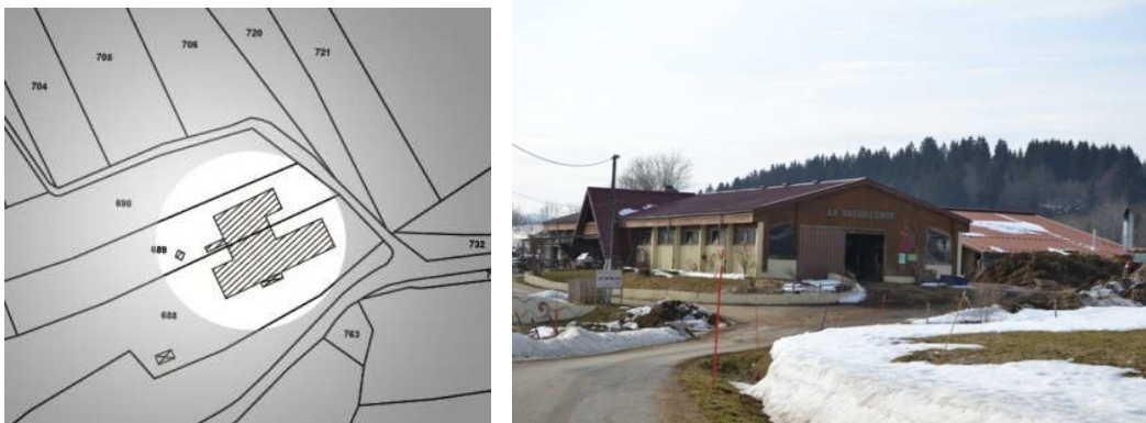
Figure 90 : Constructions de la ferme de la Batailleuse - Source : DORGAT
