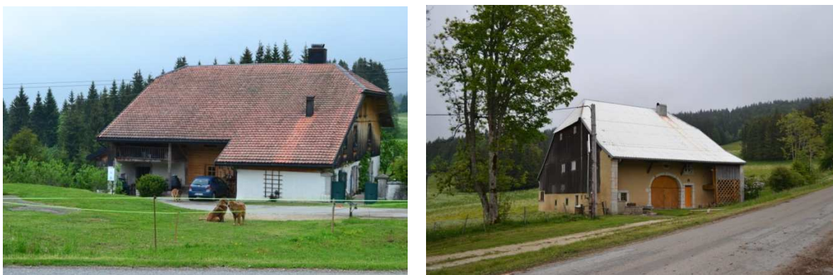
Figures 110 et 111 : Constructions au lieu-dit « Les Meix » - Source : DORGAT
