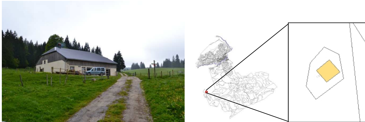
Figure 109 : La Vannode - Source : DORGAT
