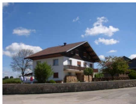
Construction intermédiaire implantée en milieu de parcelle
