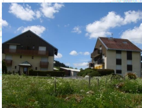
Construction intermédiaire avec toit en demi-croupe
