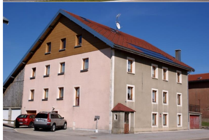
Construction plus ancienne respectant la volumétrie des anciennes fermes. Pignon en bois, mais aucun volet battant.
