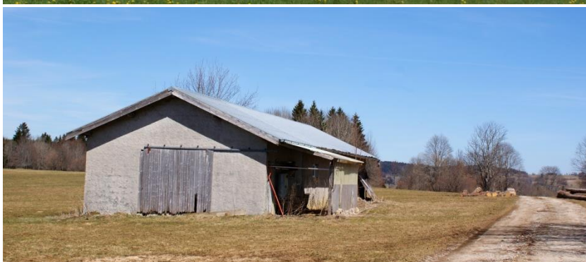
Loge : salle de traite et remise de fourrage ou de matériel.
