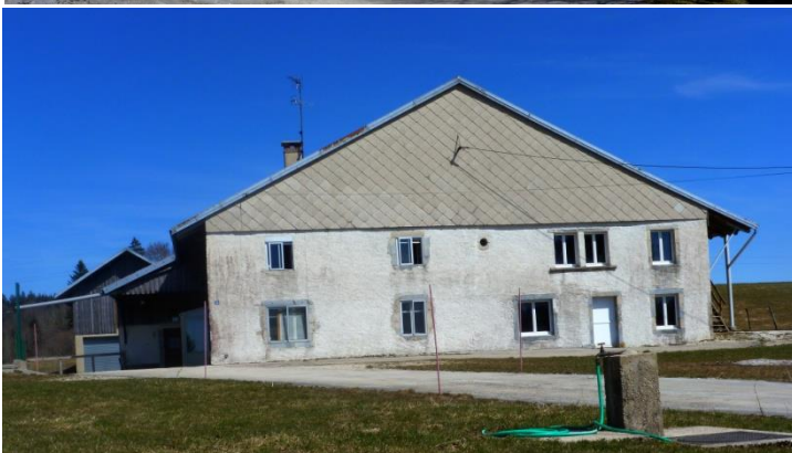
Quelques fermes anciennes sont englobées dans le tissu bâti du quartier.
