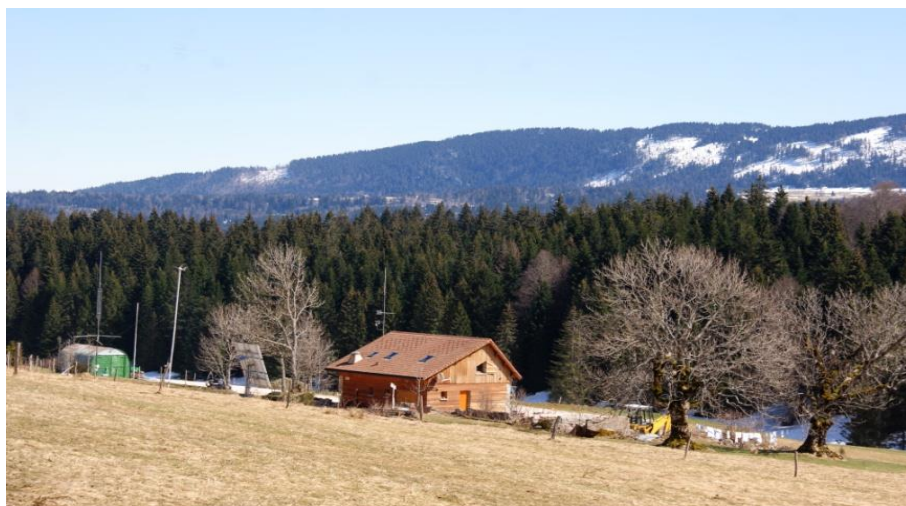
L'auberge du Vourbey reconstruite à neuf, environnée d'équipements de production d'électricité.
