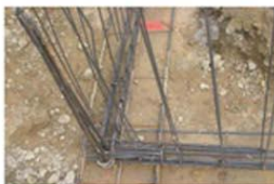
Nœud de chaînage - Continuité mécanique
