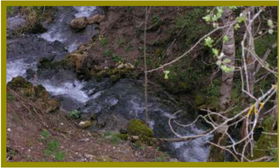
DRAINAGE TORRENTIEL DES TRONCS CHEZ TOUS, AU SUD DE LA VILLE
