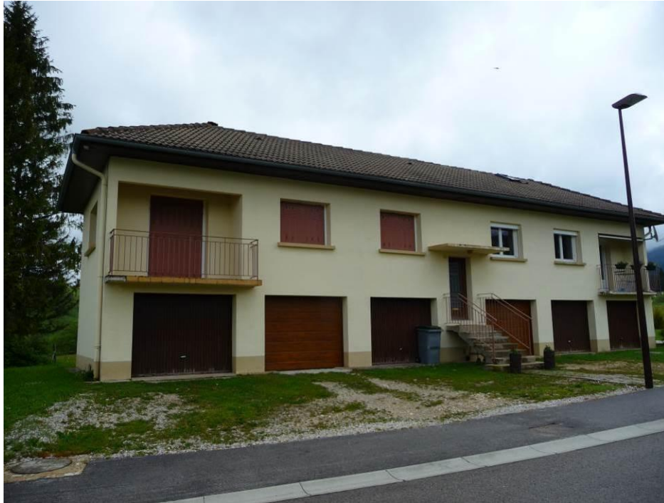
Immeuble situé rue du Doubs
