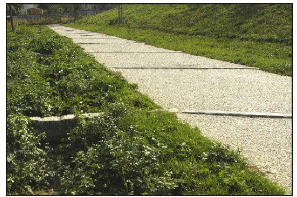
Allée piétonne et sa noue latérale
