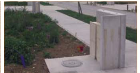
L'intégration des coffrets dans un petit muret construit à l'identique sur l'ensemble de l'opération permet d'en réduire l'impact.
