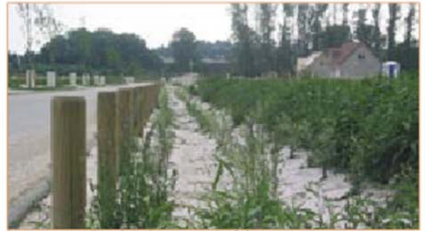
Une noue collectrice des eaux pluviales.
