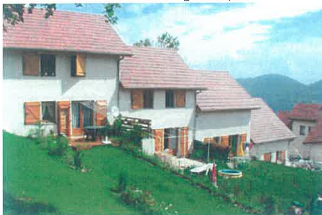
Habitat semi-collectif intégré à la pente
