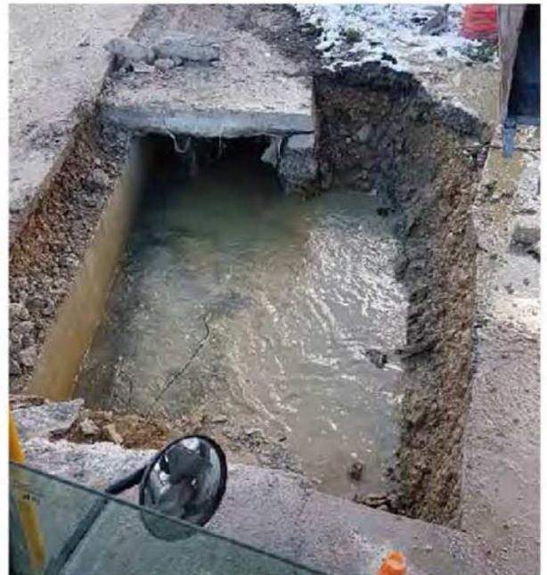
Des blocs d'enrochement ont été disposés pour refaire le bord du canal éboulé. Pour renforcer celui-ci, une pré-dalle a été installée, surmontée d'une épaisseur supplémentaire de béton et d'une couche d'enrobé pour la remise en état de la route.
