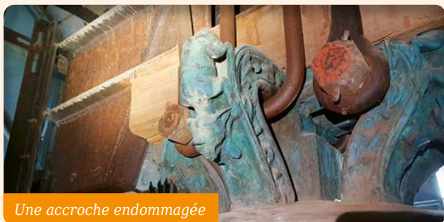
Un battant fissuré
