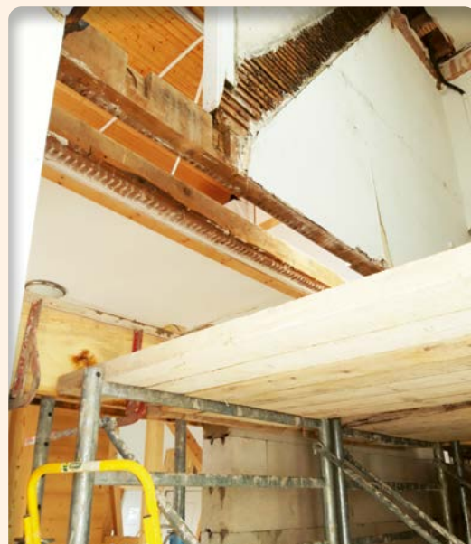
L'entreprise de maçonnerie-rénovation BRENET de la Cluse et Mijoux prépare la cage d'escalier pour le futur escalier de secours de la mairie.
